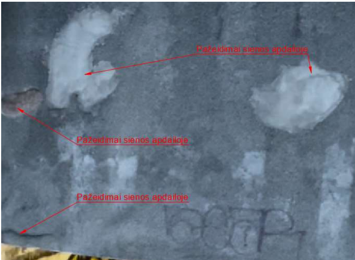
Pavekslas 11. Vaizdas į sieną virš išėjimo į Karalium Mindaugo prospektą, iš pakrantės pusės. Matomi pažeidimai sienos apdailoje, plyšiai, senų remontų žymės.
