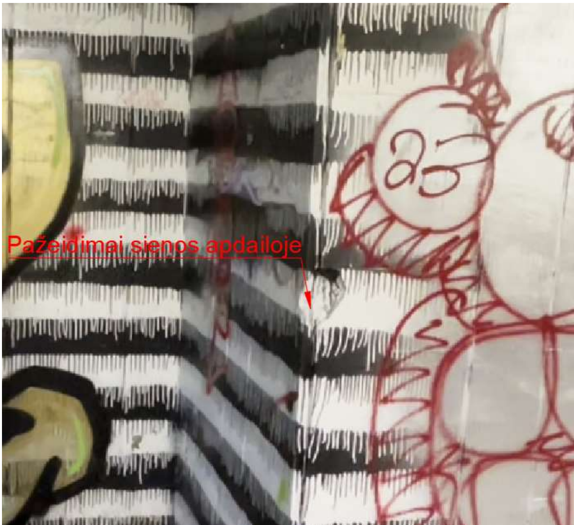
Pavekslas 9. Vaizdas į tunelio sieną. Matomi tokie pažeidimai, kaip išorinės apdailos nubyrimai, netvarka.
