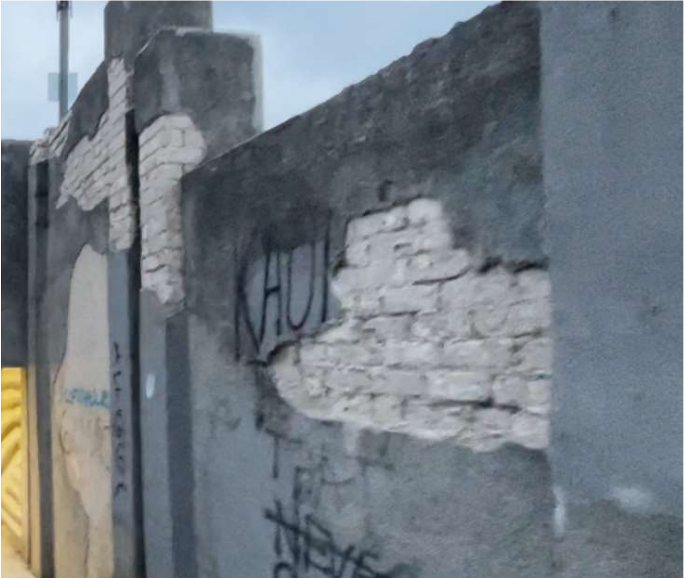
Pavekslas 3. Vaizdas į tunelio prieigas iš Kuzmos gatvės. Matoma suirusi sienos apdaila, sienos apipaišytos, netvarkingos. Nuo sienų aktyviai krenta tinkas.
